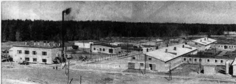
Строящийся животноводческий комплекс в п. Сибирские Огни (14 июля 1973 года)
